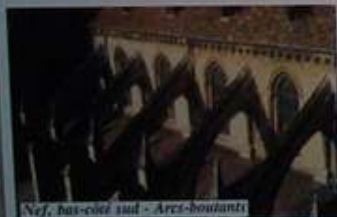
Nef, bas-côté sud - Arcs-boutants
